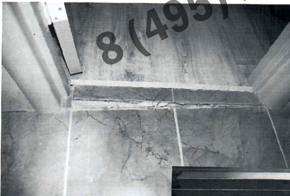
Фото 25. Повреждение облицовки пола.
